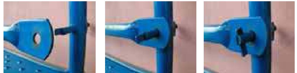
Поднять флажок на замке, надеть проушину горизонтального элемента на штырь замка, опустить флажок.
